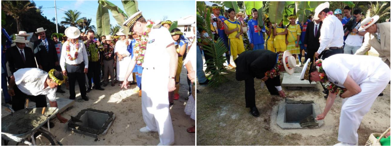
Pose des premières pierres destinées aux projets de construction de la salle omnisport et de rénovation du réseau hydraulique du village de Hauti
